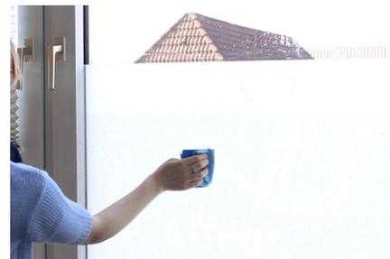
**6.** Mit der Rakel von innen nach außen über das Motiv streichen. **Rakel in das weiche Tuch wickeln, um Schäden an der Folie zu vermeiden.**
